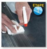
Il suffit de nettoyer la surface d'application avec une solution d'eau et d'alcool isopropylique en proportions égales et de l'essuyer pour l'assécher.
