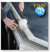
Passer un rouleau souple sur le ruban afin qu'il épouse bien le contour des formes, des bords des joints, des rivets ou des têtes de vis.
